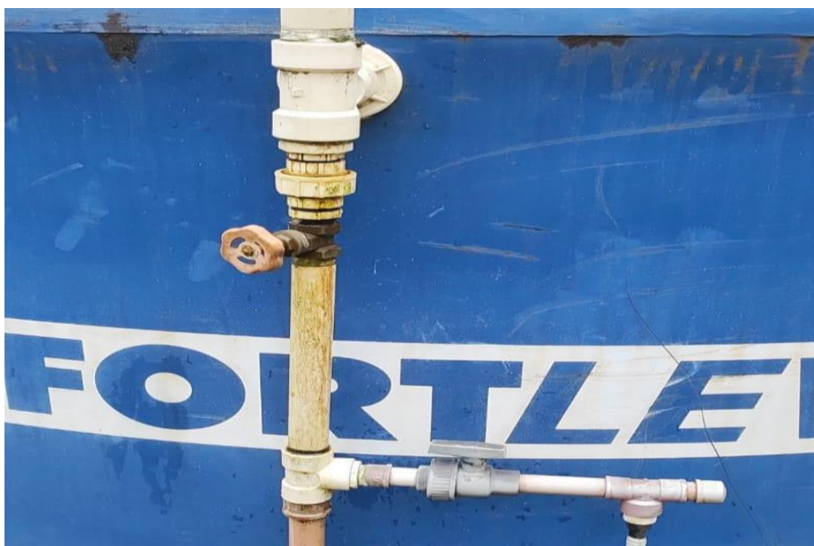
Figura 6. Sistema hidráulico utilizado para controlar a vazão do efluente do P2 para o P3.
