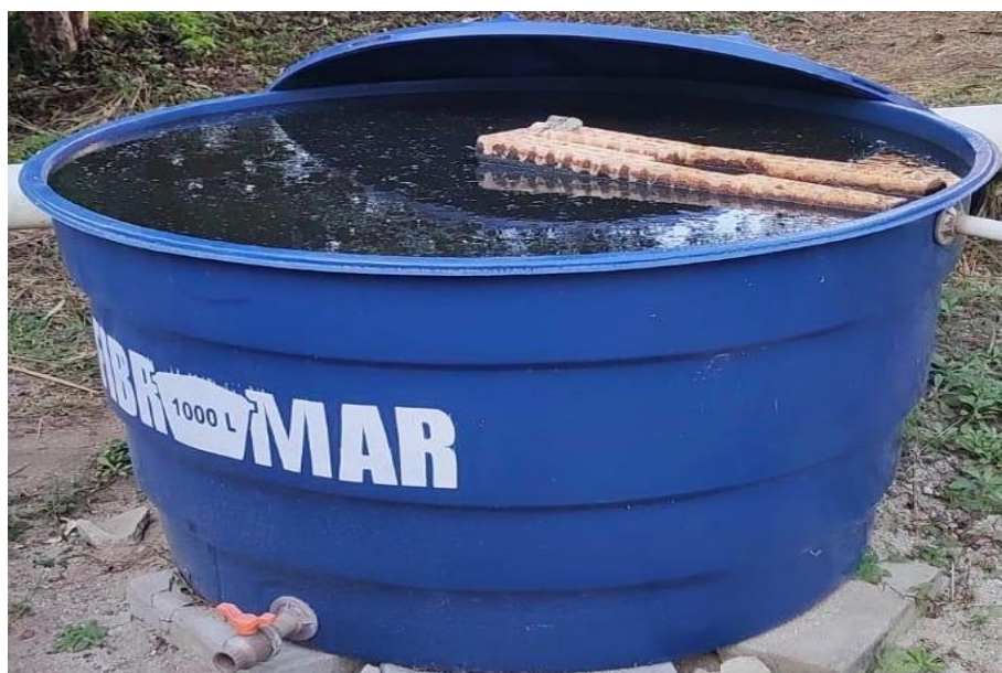
Figura 8. Filtro biológico ascendente, constituído por brita.
