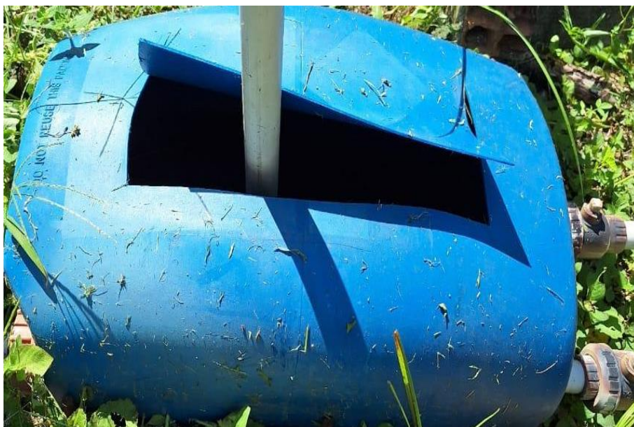
Figura 9. Caixa divisória, responsável pela distribuição do efluente nos WCs.
