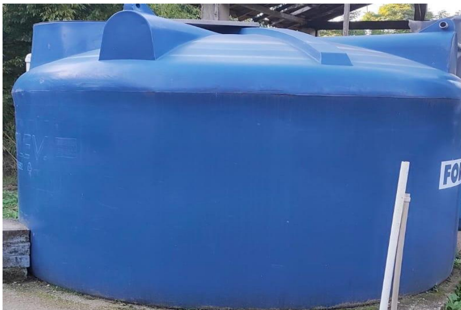
Figura 5. Tanque séptico de 10.000 L, usado para suspensão de sólido e degradação da matéria orgânica.
