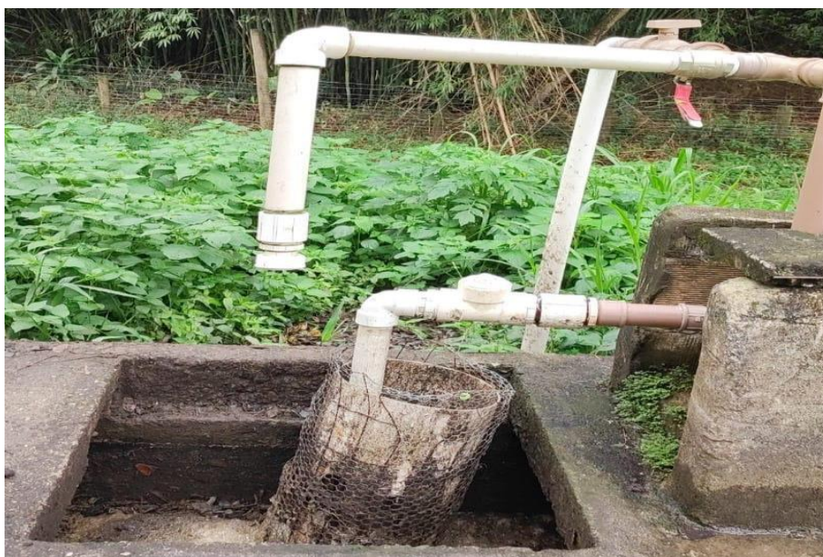
Figura 4. Esterqueira, primeiro ponto da UPT, cuja finalidade é reservar o efluente proveniente do curral.
