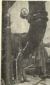
Manoel dos Santos Reis Fernandes, abrindo a Válvula de Gás de um dos Regeneradores.
