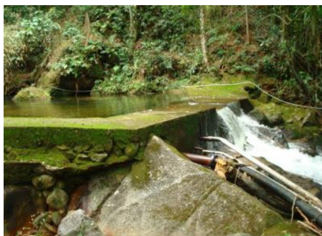
Figura 18 – Captação de água Palmital, Itatiaia, RJ.
