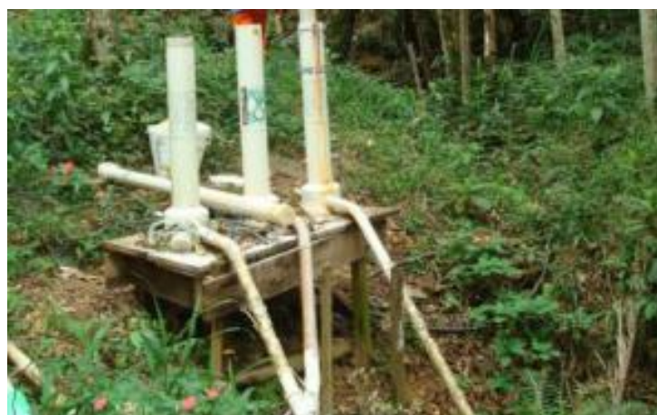
Figura 19 – Local onde é feito o tratamento da água bruta com pastilhas de hipoclorito de Cálcio na captação de água Palmital, Itatiaia, RJ.
