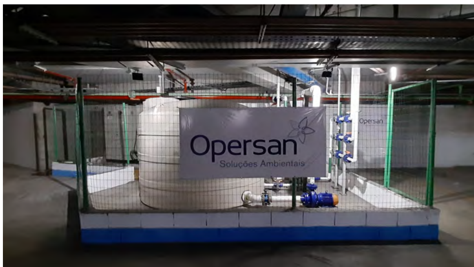
Figura 58 – Fotografia do local de captação de água de poço, com reservatório de tratamento de água, para abastecimento do Empreendimento A1 - Shopping Center , em Itaboraí – RJ.
