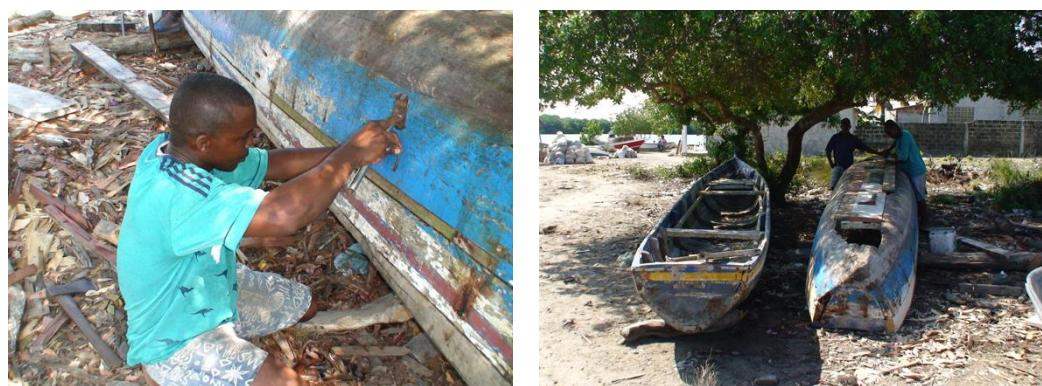
**Imagen 38. Construtor *barulero* fazendo reparos em uma chalupa**
