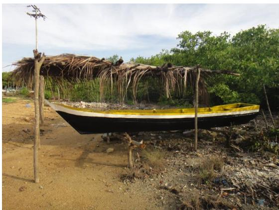
**Imagen 70. Enramada com varas de mangue para proteger uma embarcação em Barú**
