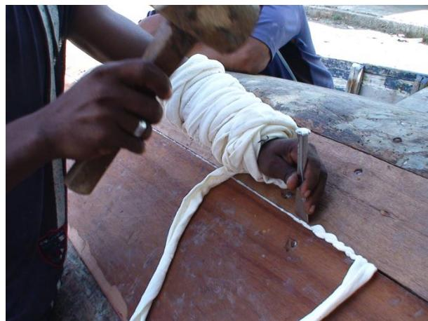
**Imagen 39. Calafetagem de uma embarcação em Barú. Observa-se a estopa e o garafate.**
