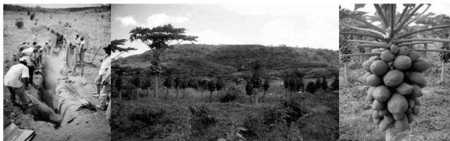
Barragem subterrânea em construção e terminada, produzindo.
