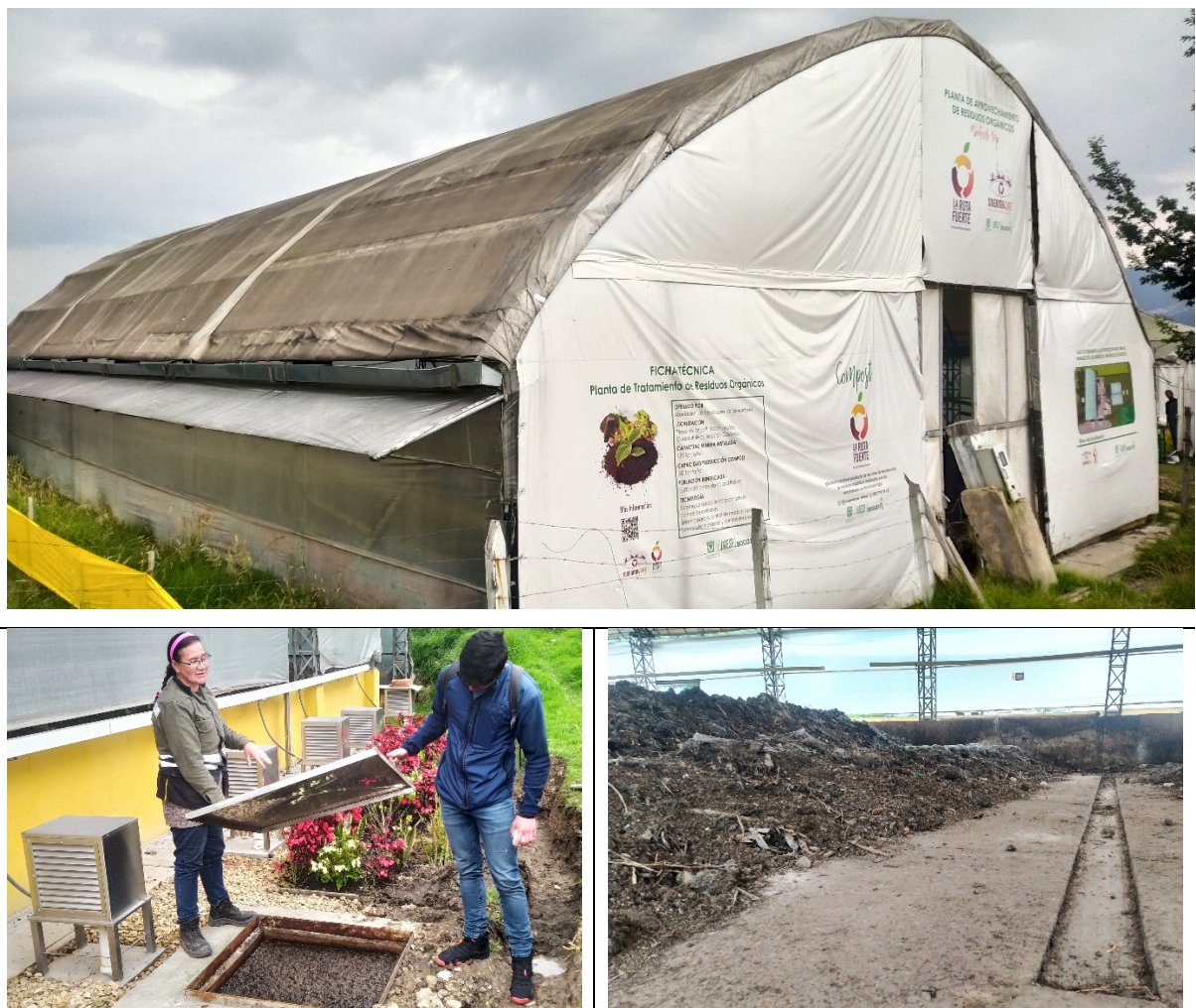
Ilustración 32 - PARSO en el 2023 con nueva cobertura e inyección forzada
