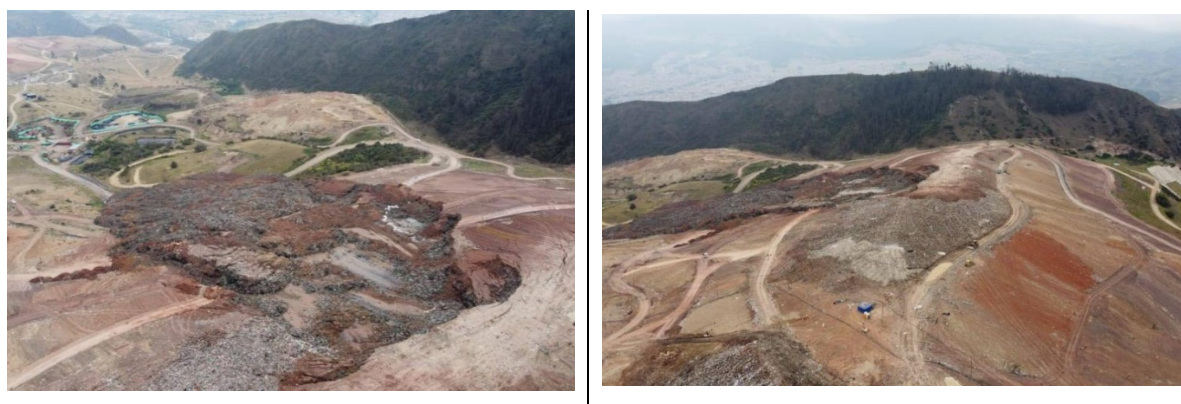
Ilustración 17 - Fotografía aérea del deslizamiento de abril de 2020
