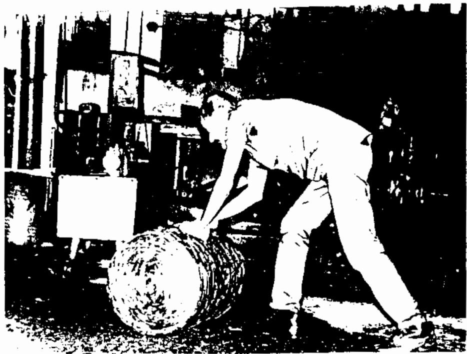
33 - Depois, o cilindro com a rebarba é roulado como um barril, para o depósito. Será revendido para reaproveitamento. São, em média, de dez a quinze por dia. Era numa posição semelhante a essa que os mais velhos operários rolavam bobinas no antigo galpãozinho, pois as bobinas eram aproximadamente desse altura.
