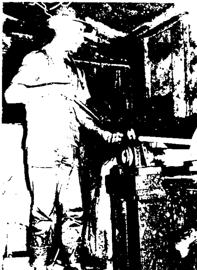
14 - Do outro lado da decapagem, na saída das lâminas, fica esse senhor. Ele joga óleo, vagarosamente, sobre o ferro que está sendo enrolado novamente para, dali ser remetido para os laminadores pesados. Nesse dia, ele estava com calça e jaqueta novas. A usina providenciou isso para muitos, sabendo que seriam tiradas fotos. Normalmente, eles trabalhavam com roupas velhas que traziam de suas casas. Nesta seção, depois de algum tempo, qualquer tecido fica com uma tonalidade amarelhada.
